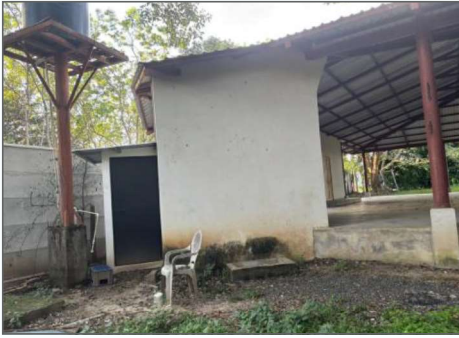
Vista de la Batería del Baño
