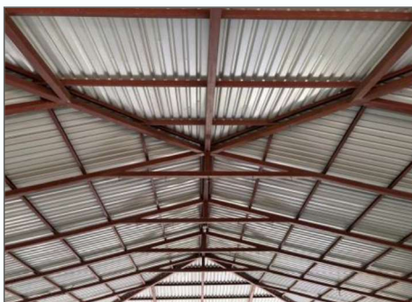
Estructura de techo y cubierta.
