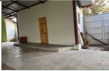
Vista oficina - dormitorio.
